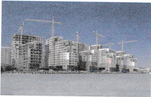
Fig. 14. Realizarea suprastructurii unei construcții
